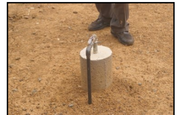
Projet Biogaz à Yona
