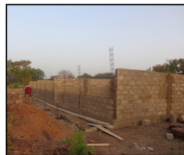
Construction de l'école de Sio
