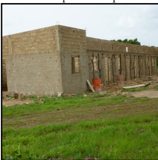
Travaux en date du 6 août
