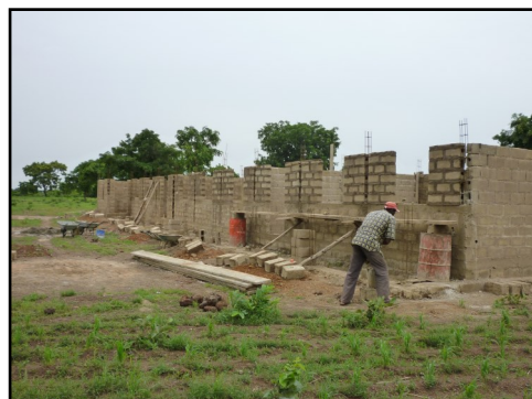
Travaux en date du 23 juillet
