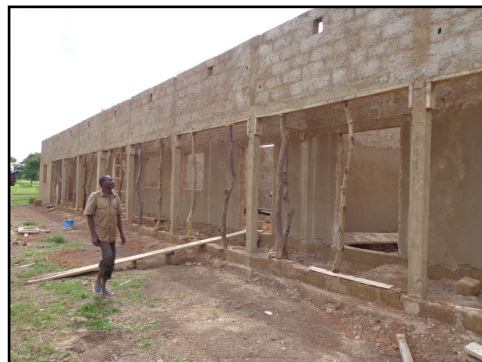
Travaux en date du 18 août
