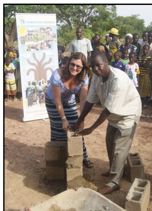
Pose de la première pierre
